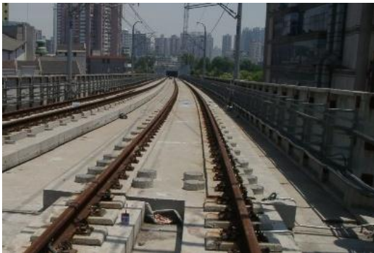
图 2. 铁路桥刚弹簧浮置板减振技术
