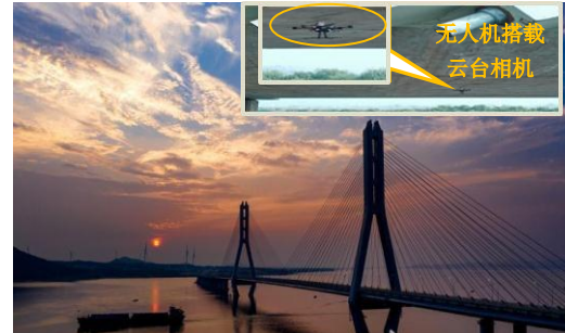
图 5. 鄱阳湖二桥裂缝自动检测
